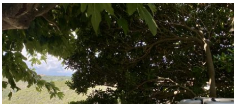
Borne de recharge pour véhicule électrique Avenue de la Carotola
